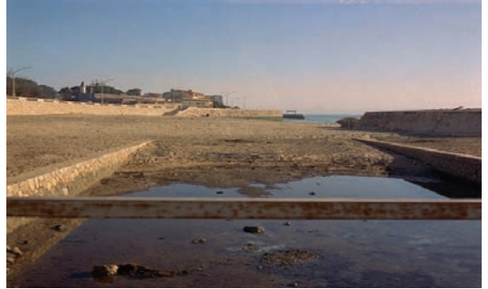
A parte final do encanamento da ribeira
