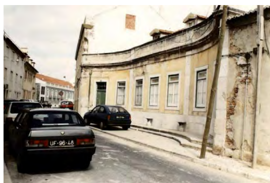
Fig. 3 - Fotografia anexa ao Proc.º de obra 4230:1994 (PT/MOER/MO/URB/o8/4230:1994).
