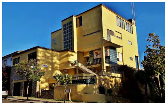
Edifício sede do CPAS. Foto de Carlos Ricardo
