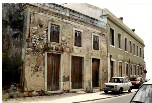
Fig. 2 - Fotografia anexa ao Proc.º de obra 4230:1994 (PT/MOER/MO/URB/o8/4230:1994).
